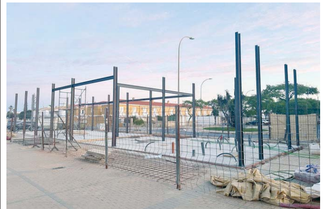
Inicio de obras. MANCOMUNIDAD ISLANTILLA
