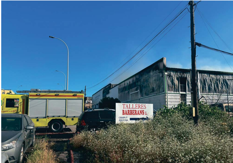
Una de las naves afectadas en el Cortijo Real. VIVA CG
